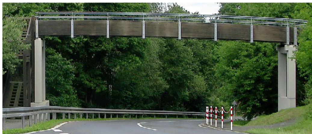
Diese Brücke im Grünen wurde 1996 gebaut, damit Fußgänger den Calderner „Ortsteil“ Stetefeld sicher erreichen können und nicht die Landesstraße im Kurvenbereich kreuzen müssen. Foto: Schaub
