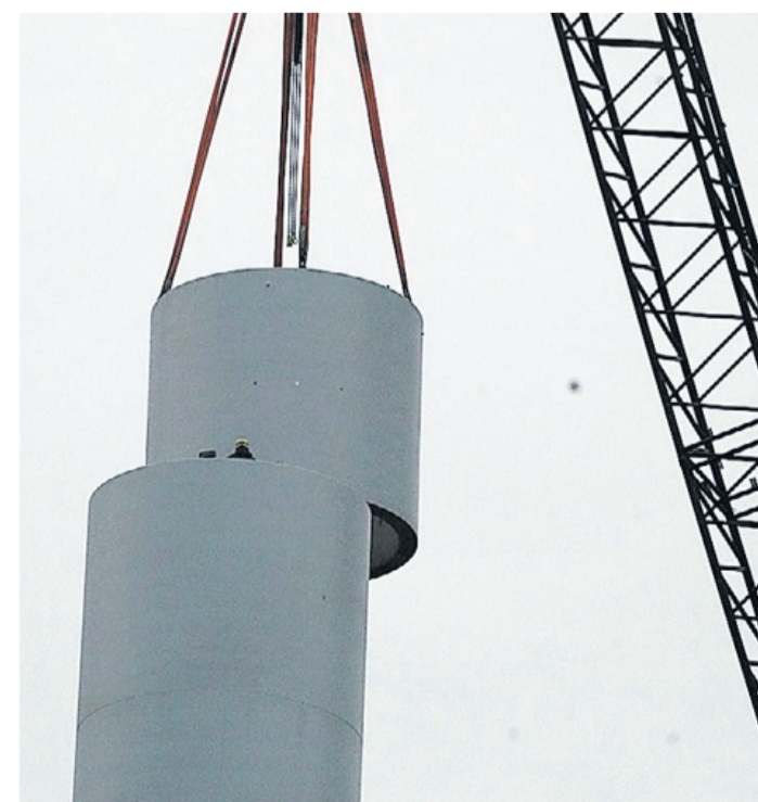
Rendezvous in luftiger Höhe: Ein Arbeiter dirigiert über Funk den Kranführer, der das tonnenschwere Bauteil exakt aufsetzt.
