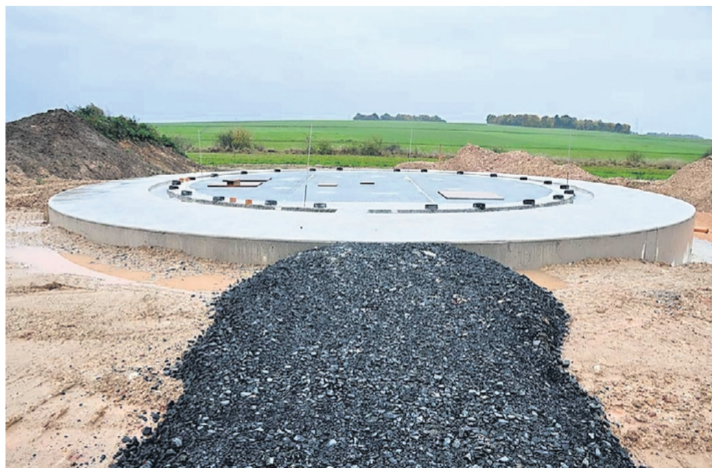
Nur drei Meter tief, dafür aber 1 000 Tonnen schwer: Diese Fundamentscheibe wird den 142 Meter hohen Turm des Windrades Nummer drei tragen.
